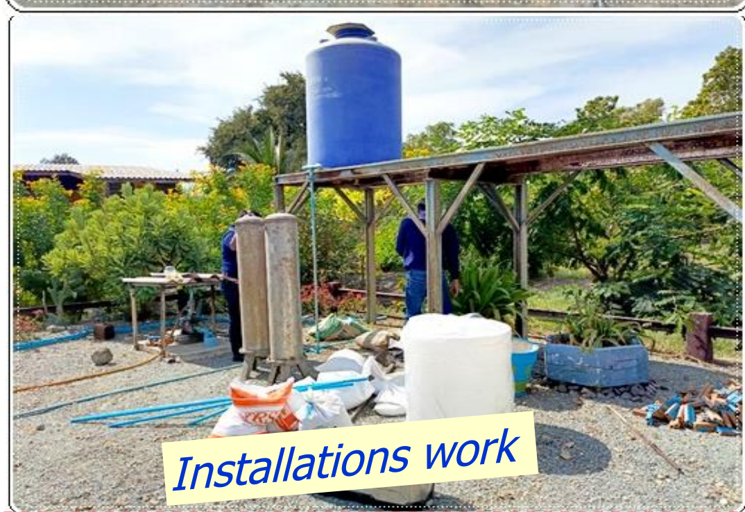
คุณภาพน้ำหลังแก้ไขติดตั้งระบบกรองทรายและระบบ Softener filter
